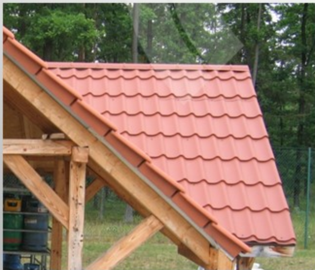
Dach pokryty blachodachówką o nachyleniu 40^{\circ}
